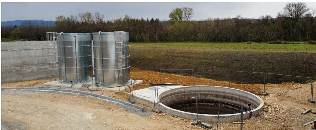
Figure 10: Préfosses aériennes (à gauche) et préfosse enterrée (à droite)
